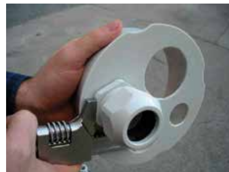
3. Установить и зафиксировать кабельные вводы.
