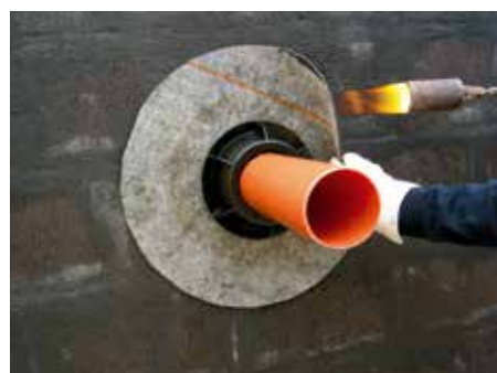
5. Приварить мембрану к битумному покрытию стены
