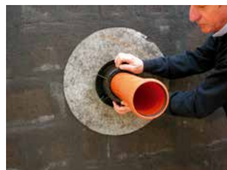
6. Затянуть фиксирующую гайку
