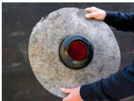
2. Надеть гидроизоляционную мембрану
