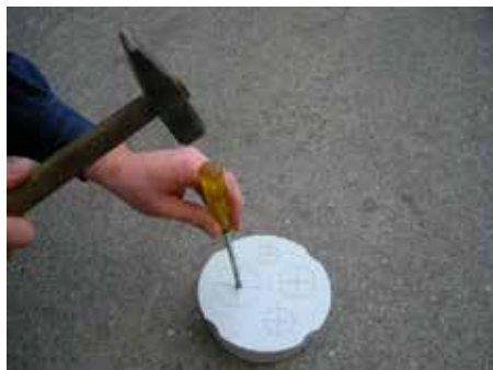
2. В монтажном элементе подготовить отверстия нужного диаметра
