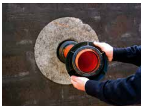
4. Установить фиксирующую гайку
