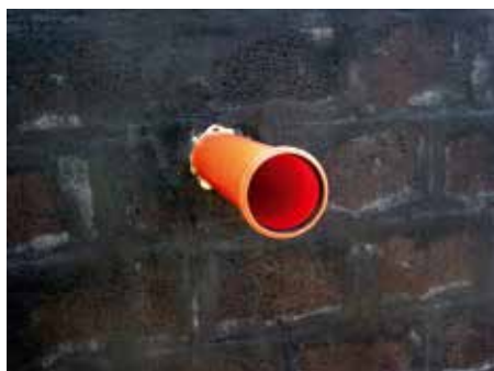
1. Труба проведена через стену с битумным покрытием.
