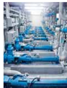
Насосы seerex BN 52-6L. Продукт: сгнивший шлам в обезвоживающих центрифугах.
