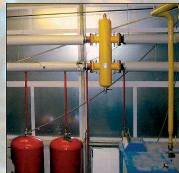
Сепаратор Spirocross разработан для воды и водных растворов этиленгликоля (макс. 40%) и может устанавливаться в комбинации с допускаемыми химическими растворами/добавками по местным предписаниям, которые подходят для применяемых в системе субстанций. Данное оборудование не подходит для питьевой воды.
