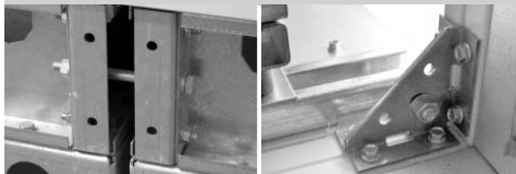
Рис. 10 - соединение рам и секций
