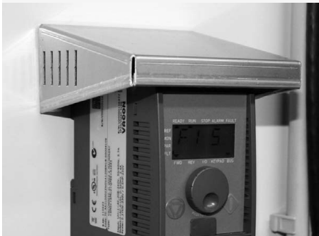
Рис. 2 – кожух частотного преобразователя (IP4X)
