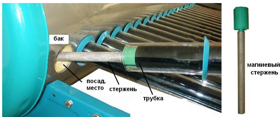
Рис. 4 Способ установки магниевого стержня
