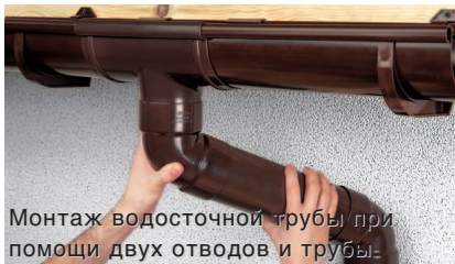
Монтаж водосточных труб
