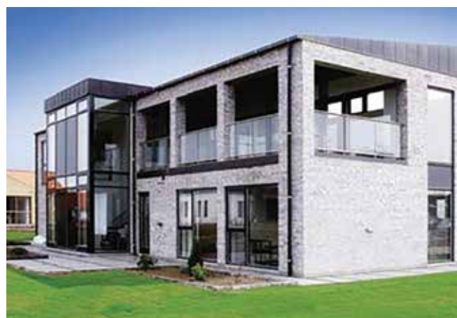
Багатоповерхові та приватні житлові будинки
