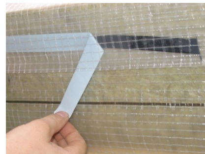
Герметизація шва «плівка до плівки» з використанням двосторонньої бутилової стрічки
