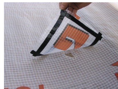
Герметизація пошкодженої плівки за допомогою двосторонньої бутилової стрічки
