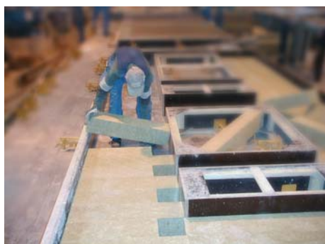
Монтаж ламелей PAROC FAL1 в заводских условиях.
