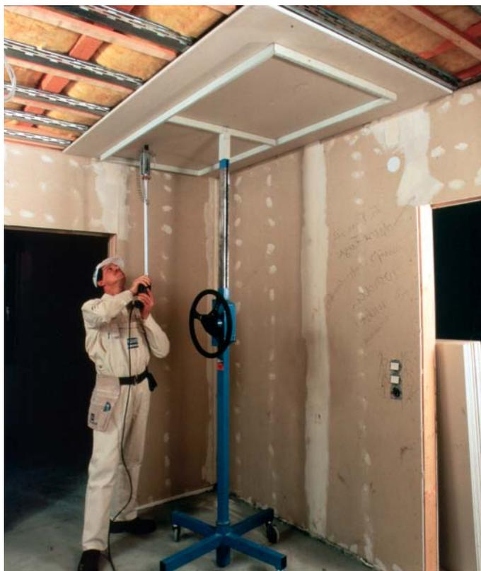
Закрепить гипсокартонные плиты быстромонтируемыми дюбелями. Метростат 300 помогает зафиксировать положение плиты.
