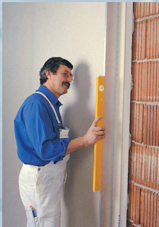
Приклеивание комбинированной плиты Кнауф на каменную кладку.
