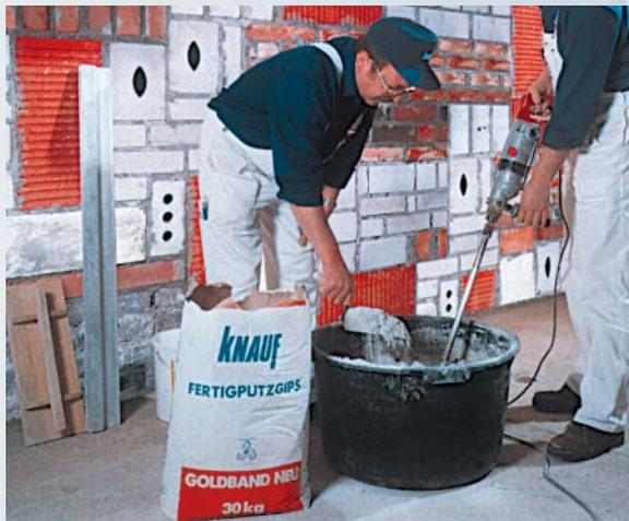
Порошок из мешка затворяется водой и замешивается с помощью смесителя.
