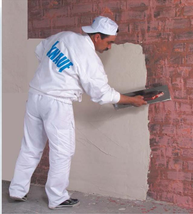
Штукатурки для ручной обработки для любых оснований и любой области применения, особенно при производстве ремонтных работ. Сухая смесь затворяется водой и замешивается смесителем. Для больших площадей в программе Кнауф имеются машинные штукатурки как для внутренних, так и для наружных работ.
