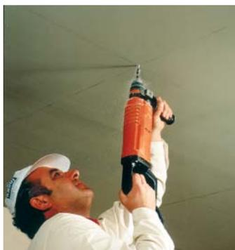
Монтаж очень прост: просверлить отверстия под подвесы согласно разметке.
