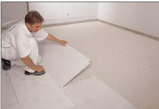
Надежное соединение. Первый и второй слои плит укладываются со смещением, склеиваются друг с другом....
