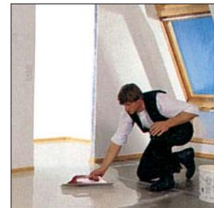
Идеально для тонкослойных покрытий как ПВХ или линолеум. Шпаклевать только специальной шпаклевкой Кнауф 415. Самовыравнивающаяся шпаклевочная масса для слоев толщиной 2 - 15 мм. Готово.
