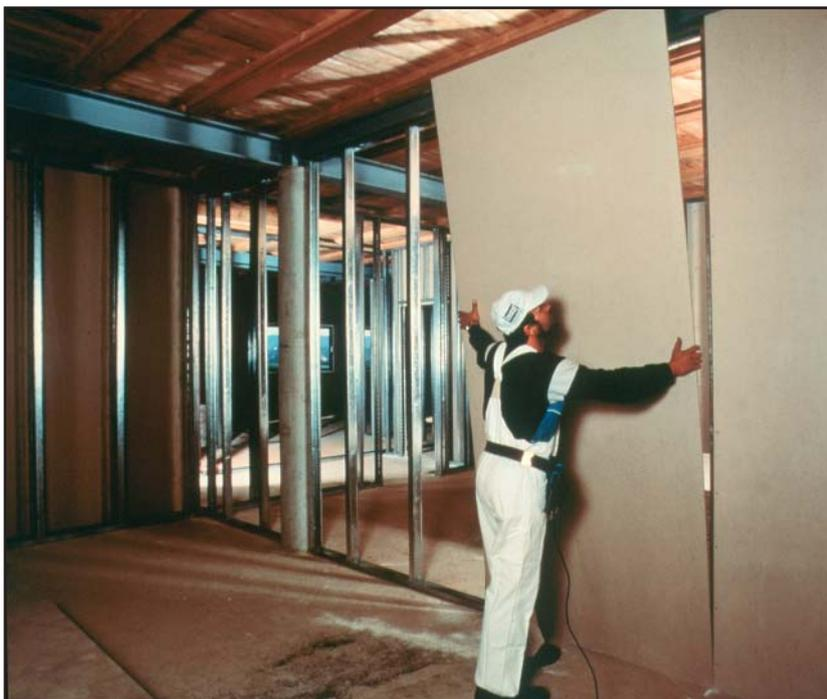
Монтаж стоечных стен Кнауф
