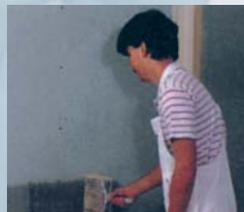
Перед укладкой облицовочной плитки наносится Кнауф Тифенгрунд с помощью кисти - макловицы
