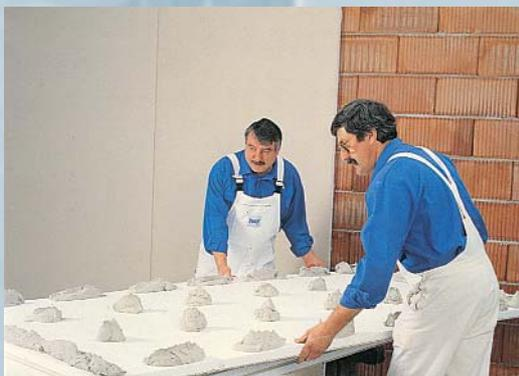
Плита поднимается и прижимается к стене.
