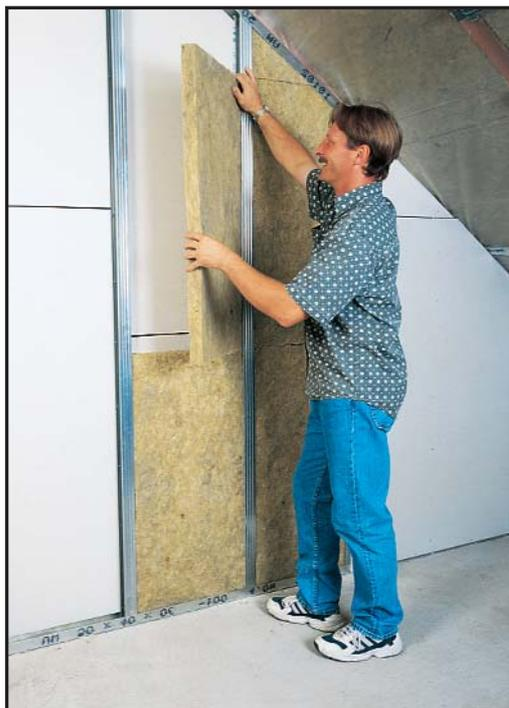
Пространство между ГКП заполняется изоляционным материалом из минерального волокна
