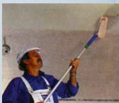
При не впитывающем, плотном бетонном основании поверхность следует предварительно обработать Кнауф Бетоконтакт с помощью валика с цигейковой "рубашкой"
