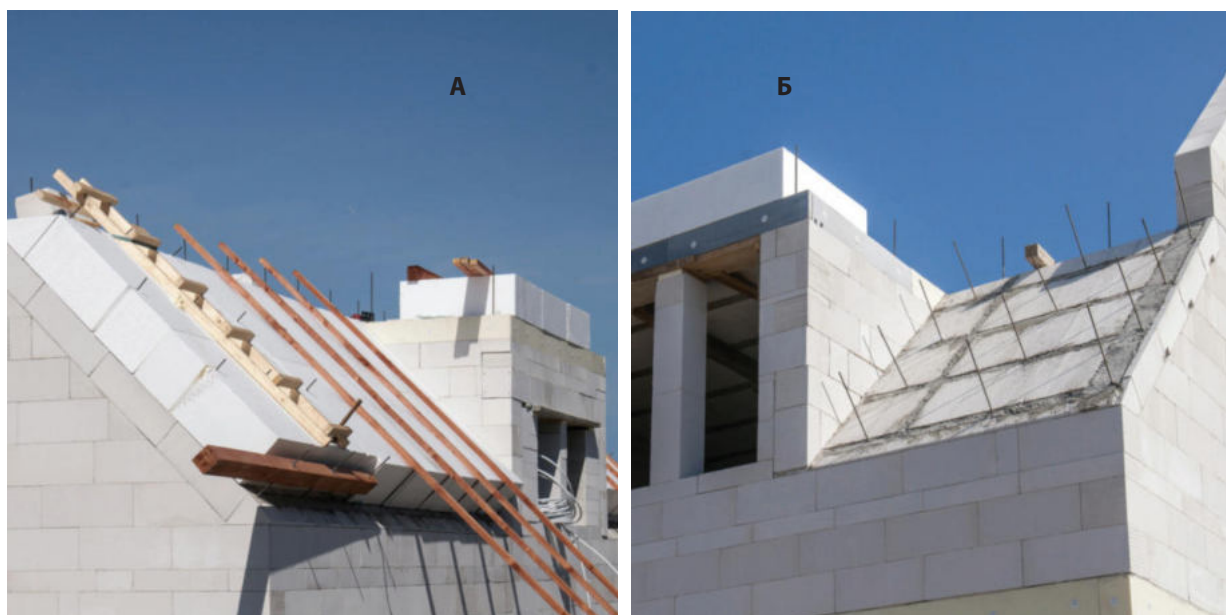
Мал. 7.17 Скатна покрівля з а) газобетонних армованих плит покриттів; б) збірно-монолітних покриттів з використанням газобетонних блоків
