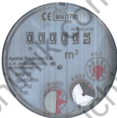
Рисунок 3. Показувальний пристрій великого лічильника номінального діаметру DN65
