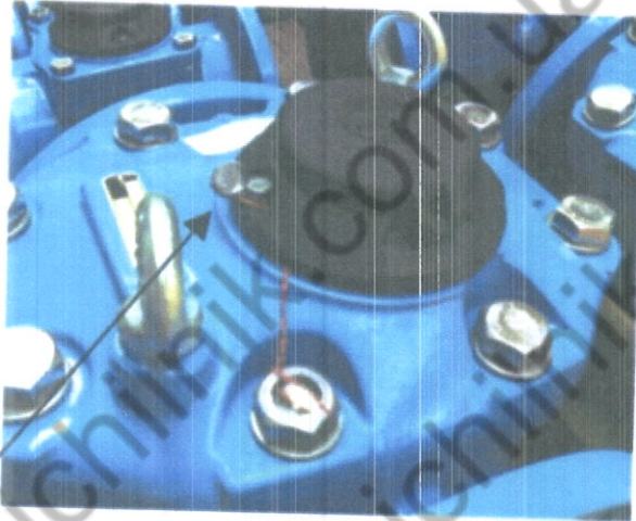
Рисунок 8 – Місця пломбування лічильника модифікації MWN DN200
