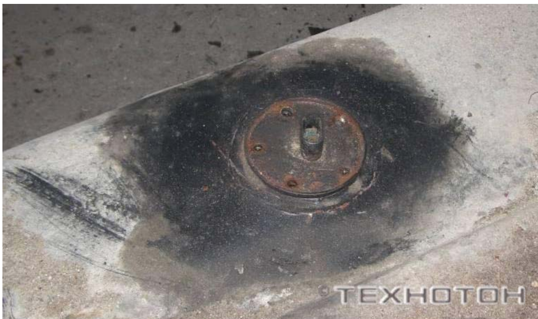
Очистка места установки
