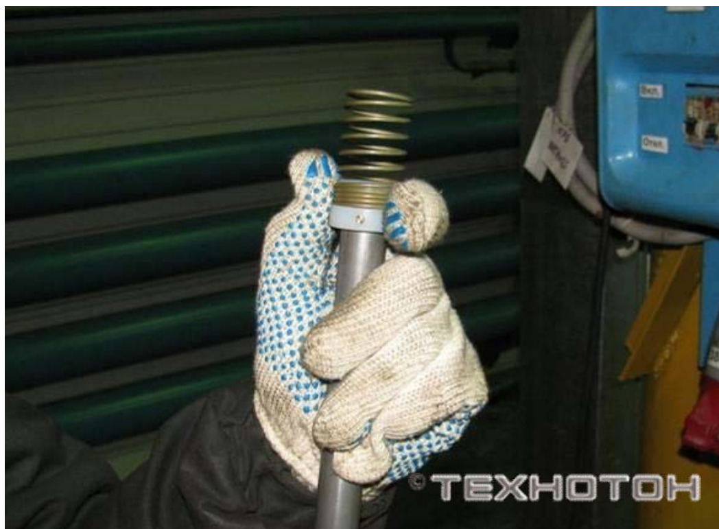
Установка донного упора
