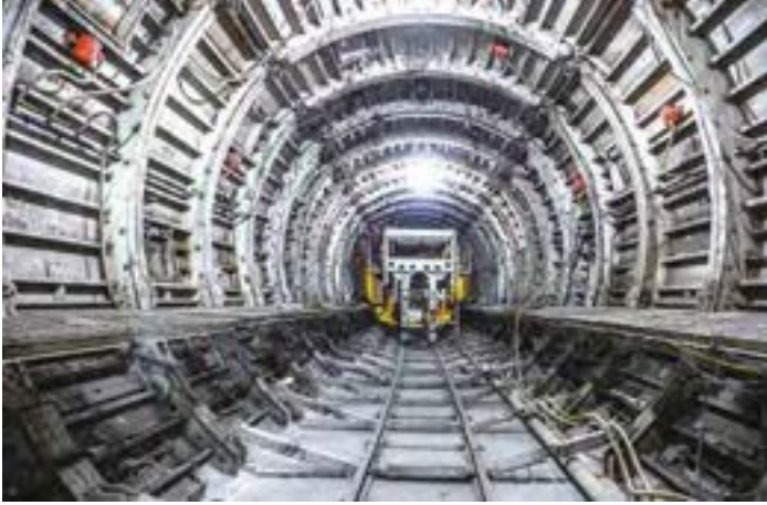
Tünel İnşaatı / Tunnel Construction
