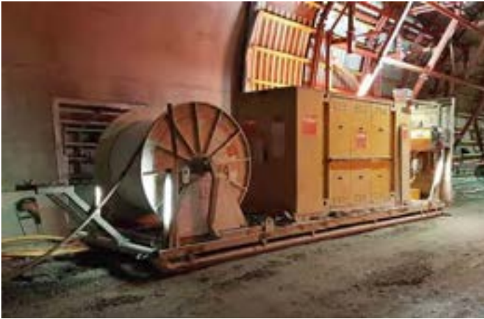
Tünel İnşaatı / Tunnel Construction
