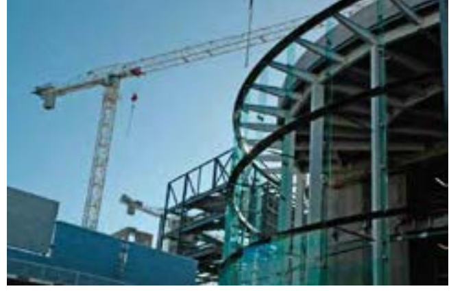
İNŞAAT SEKTÖRÜ CONSTRUCTION FIELD
