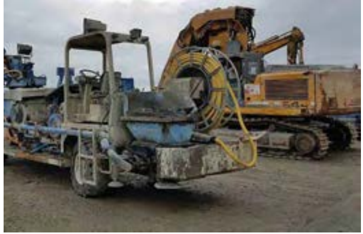
Tünel İnşaatı / Tunnel Construction
