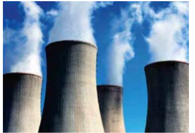
ENERJİ ÜRETİM VE DAĞITIM SİSTEMLERİ POWER GENERATION AND DISTRIBUTION SYSTEMS
