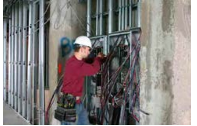
ELEKTRİFİKASYON İŞLERİ ELECTRICAL INSTALLATION WORKS
