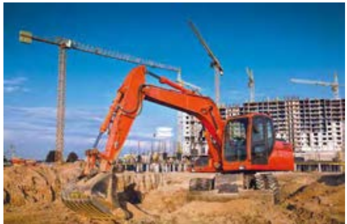
İnşaat Alanları / Construction Site
