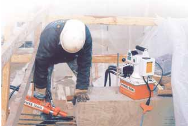
Применение насоса модели PE60 для создания предварительного напряжения арматуры
