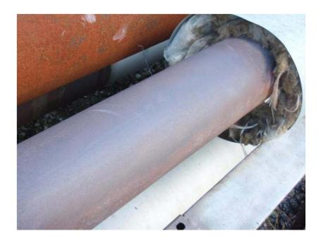
На подготовленную поверхность паропровода кистью был нанесен один слой антикоррозионного грунта  $\Gamma\Phi$ -021.
