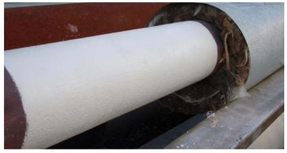
Покрытие из композиции полимерминеральной «Керамоизол» кистью было нанесено на паропровод толщиной в 3 мм.
