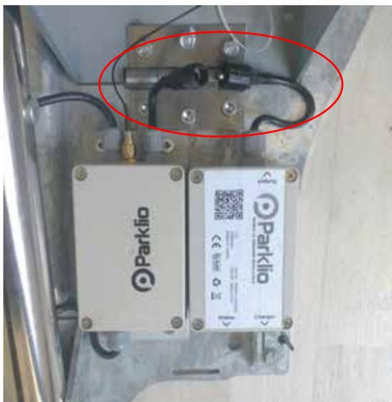
Рисунок 13 - Подключение источника питания
