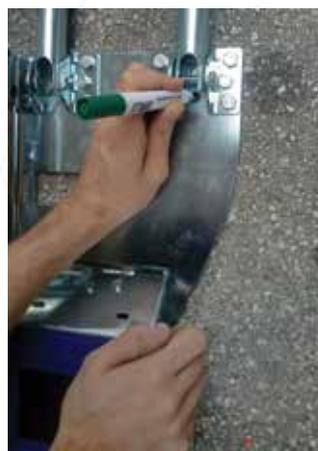
Рисунок 8 - Маркировка мест сверления
