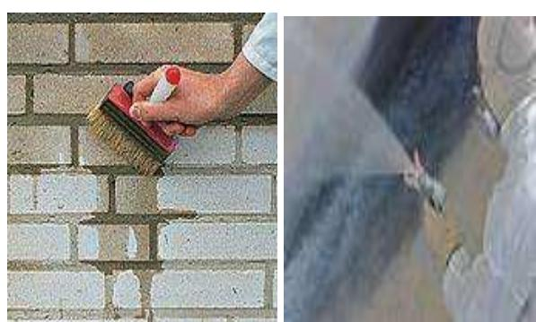
Грунт-пропитка наносится методом безвоздушного распыления, либо меховым валиком до насыщения. На протяжении периода высыхания поверхности не допускать попадания влаги и других загрязнений механического или химического типа.
