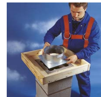
Применение металлической манжеты для заливки покровной плиты по месту.
