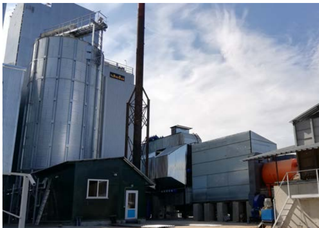
Косвенный воздушнонагреватель "STELA" с теплогенератором "TEFF"
