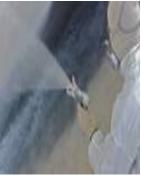
Грунт-пропитка наносится методом безвоздушного распыления, либо меховым валиком до насыщения. На протяжении периода высыхания поверхности не допускать попадания влаги и других загрязнений механического или химического типа.
