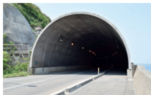
Туннели, бетонные трубы/кольца
