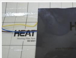
Поверх греющих элементов уложить защитный заземляющий слой **E-DERO™ Heat Plus**, с подключением провода к заземлению.
