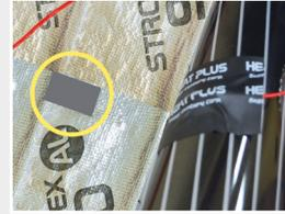
Подключить терморегулятор, согласно Инструкции производителя, с выводом и закреплением термодатчика с помощью **Изоляционной Ленты™ Heat Plus** на греющей части пленки. Для термодатчика нужно сделать углубление в основании, во избежание механического повреждения.
