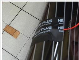
Подключить терморегулятор, согласно Инструкции производителя с выводом и закреплением термодатчика с помощью **Изоляционной Ленты™ Heat Plus** на греющем элементе пленки. Для термодатчика нужно сделать углубление в основании, во избежание механического повреждения.
