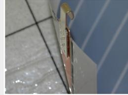
Закрепить **клипсы-коннекторы** на медной шине нагревательных элементов, с помощью **Пресса** либо плоскогубцев.
