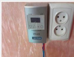
Подготовить место для терморегулятора, по близости имеющейся проводки, на расстоянии не более 2 м от выносного термодатчика (сенсора), который есть в комплекте терморегулятора.
