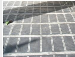
Накрыть все нагревательные элементы полиэтиленовой пленкой с запасом 10 см. по периметру, и завернуть ее под нижний теплоотражатель так, чтобы получился «конверт».
