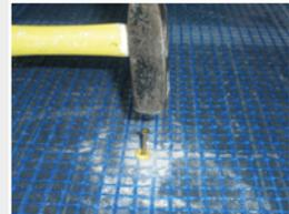
В местах отреза, где отсутствуют токопроводящие и карбоновые элементы пленок, сквозь монтажную сетку, полиэтилен, нагревательную пленку и теплоизоляцию осуществляется бурение пола буром D=6 мм. В прорезанные отверстия забиваются дюбеля.
