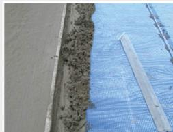
После проверки работы, систему отключить от электросети и выполнить заливку стяжки (2-3 см).
