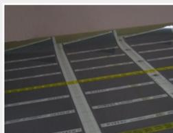
Разместить нагревательные пленки <sup>TM</sup>Heat Plus на запланированной поверхности и закрепить скотчем. **Внимание!!!** Пленки укладывать только встык, не допускается наложение пленок. Не укладывать под стационарную мебель, которая закрывает отвод тепла.
