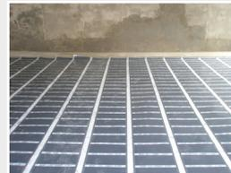
Разместить нагревательные пленки **™Heat Plus** на запланированной поверхности и закрепить скотчем. **Внимание!!!** Пленки укладывать только встык, не допускается наложение пленок, не укладывать под стационарную мебель, которая закрывает отвод тепла.
