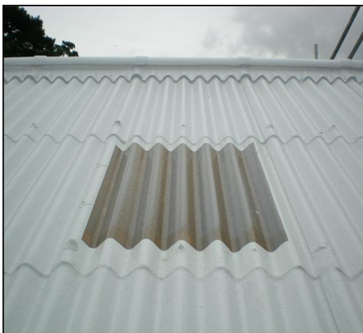
Ремонт существующей шиферной кровли.
