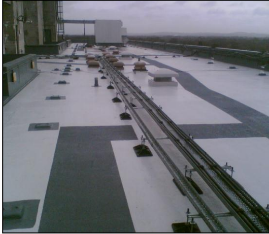
Ремонт существующей битумной кровли.
