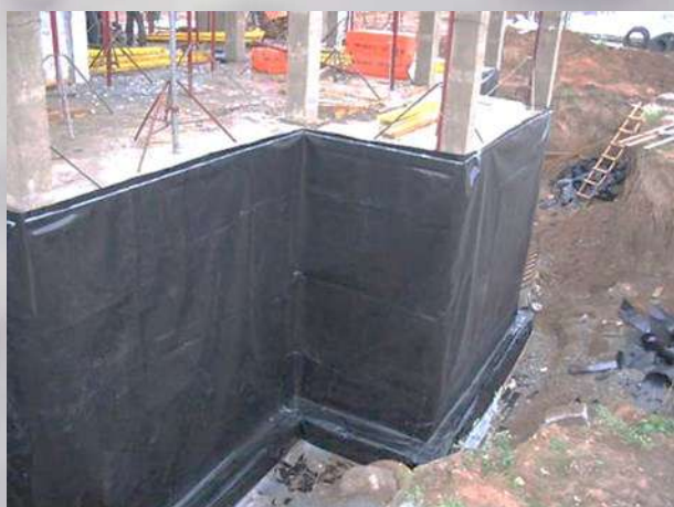
Частный дом (гидроизоляция фундамента), г. Херсон, 160 м 2
