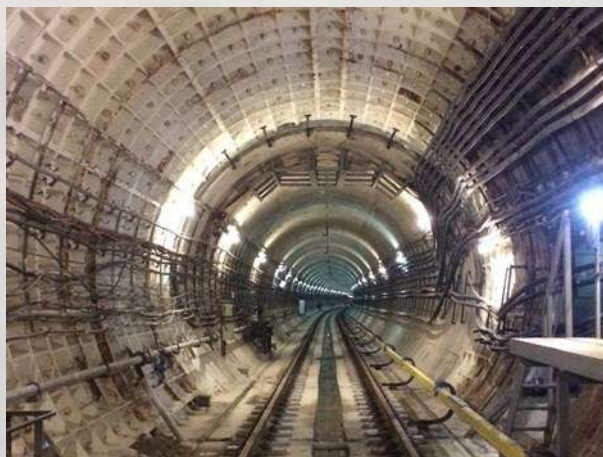
Метрополитен (гидроизоляция туннеля), Австрия, 27 000 м²
