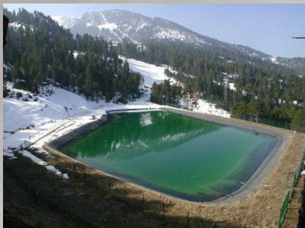
Резервуар для хранения воды, г. Коломья, 3 000 м²
