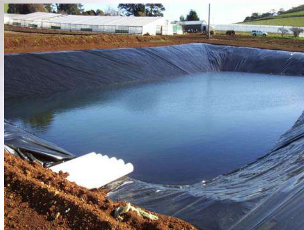
Резервуар для полива, г. Умань, 1 800 м²
