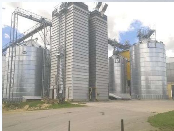
Корпорация «АГРОПРОДСЕРВИС», г. Тернополь, 23 500 м 2
