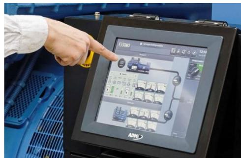
Пульт контроля и управления **APM802** предназначен для управления и отслеживания работы электростанций, используемых в больницах, информационных центрах, банках, в нефтегазовом секторе, в горно-рудной отрасли, в промышленности, независимыми производителями энергии, а также в случаях аренды.
