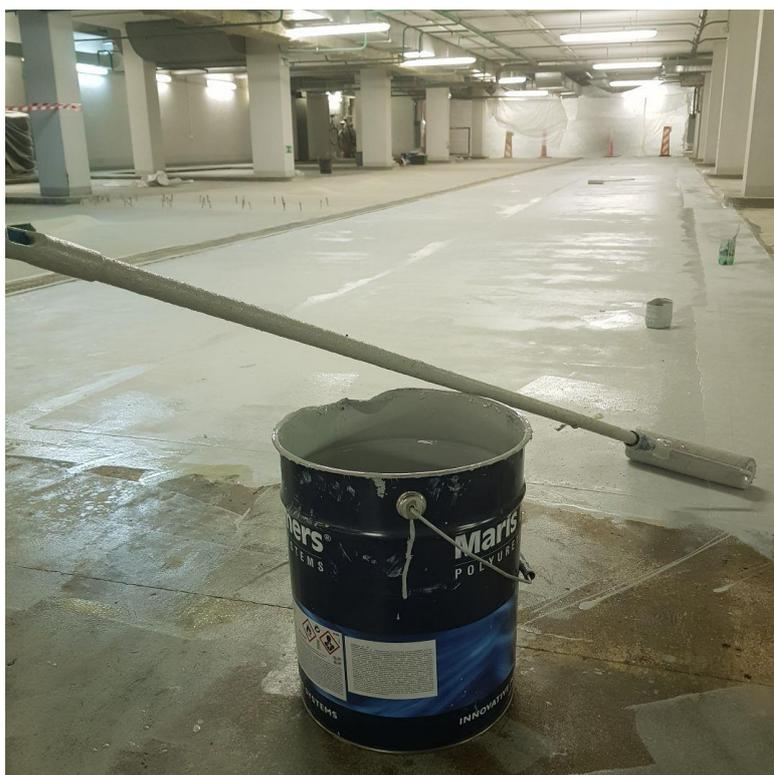
2. Грунтование поверхности «Mariseal 710» и нанесение гидроизоляционного слоя мембраны «Mariseal 250»
