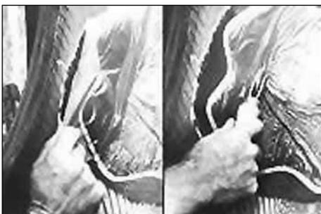
48. Снимите оставшуюся синюю защитную пленку с краёв пластыря. Прикатайте весь пластырь роликом от центра к краям.
