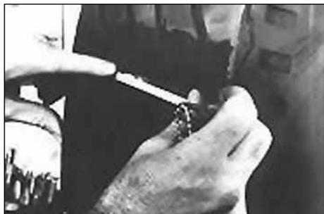
16. Для определения времени вулканизации Вам необходимо знать максимальную толщину шины в месте повреждения. Измерьте максимальную глубину пореза. Напишите размеры на внешней стороне шины для дальнейшего использования.
