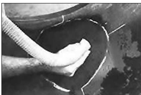
45. Очистите пылесосом обработанную область для удаления металлической стружки, мелких частиц резины и резиновой пыли.
