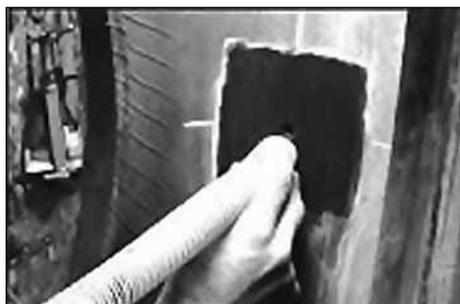
13. Очистите пылесосом обработанную область для удаления металлической стружки и резиновой пыли.
