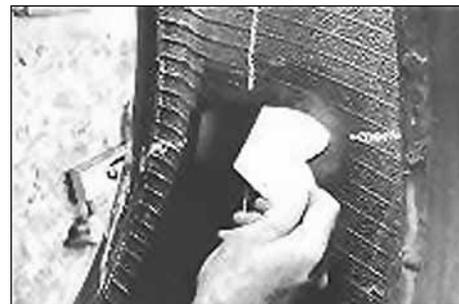
35. Снимите с сырой резины защитную полиэтиленовую пленку.
