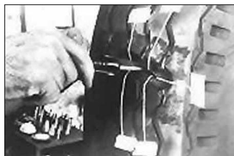
29. Аккуратно уложите сырую резину Vul-Gum в месте пореза шины с помощью тупого предмета, например, инструмента для укладки резины № 986. Не старайтесь заполнять сразу большую область, так как Вы можете оставить прослойки из воздуха в резине. Чем меньше Вы оставите воздушных мешков между уложенными слоями резины, тем меньше будет пористость резины в месте ремонта после вулканизации. Укладывайте резину до тех пор, пока не сможете перейти к ролику № 936 (Stitcher).
