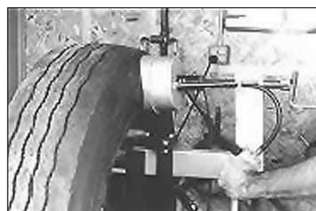
38. Установите пневмоприжим на вулканизаторе, подсоединив линию подачи воздуха. Подайте давление воздуха не более 2 атм (бар). Если Вы используете ручной вулканизатор, то Вам необходимо снова затянуть его через 5-10 минут после начала процесса.
