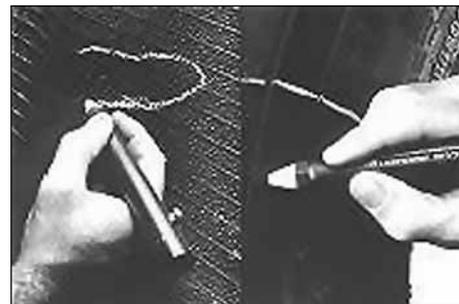
2. Обозначьте место повреждения с внешней и внутренней сторон шины с помощью маркировочного мела № 951. Удалите предмет, вызвавший повреждение.
