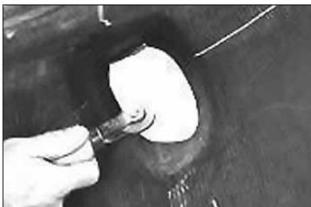
27. Тщательно прикатайте полоску сырой резины с помощью ролика закаточного № 936 (Stitcher).
