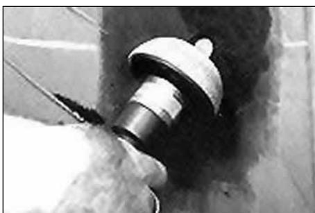
20. Обработайте шину с внутренней стороны вокруг повреждения по периметру (от 40 до 50 мм) контурным кругом RH-102 совместно с полиуретановой вставкой RH-152. Скорость вращения пневмошеровальной машинки при обработке не должна превышать 5000 об/мин.
