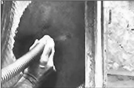
42. Очистите пылесосом обработанную область для удаления металлической стружки, мелких частиц резины и резиновой пыли.
