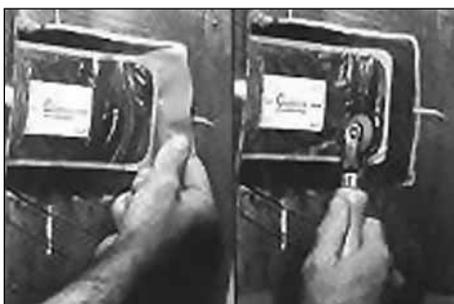
37. Снимите оставшуюся синюю защитную пленку с краёв пластыря. Прикатайте весь пластырь роликом движениями от центра к краям.
