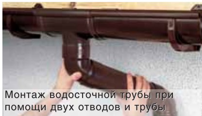
Монтаж водосточных труб
