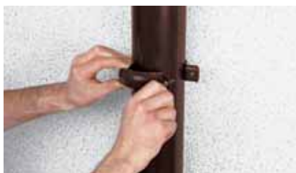
Крепление водосточных труб к стене из дерева или металла
