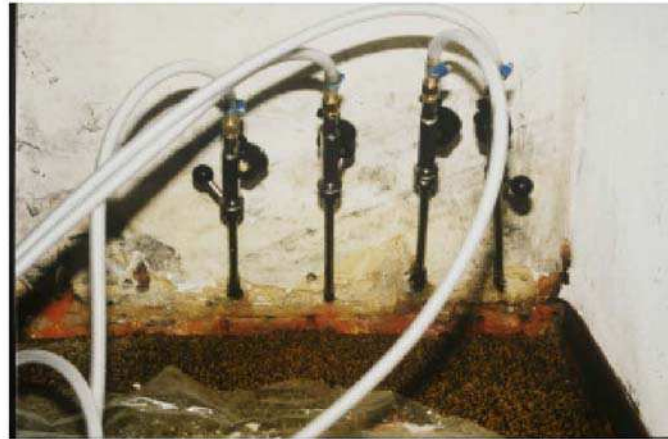
Формирование гидроизоляционных прослоек
