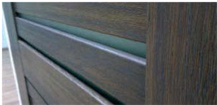
Скляні вставки (матові), між горизонтальними складовими полотна
