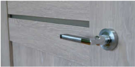
Скляні вставки (матові) між горизонтальних складових полотна
