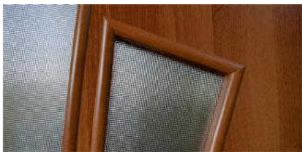
Скло «Кризет» встановлене з обкладом (овальний)
