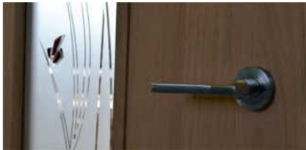
Скло матове з прозорим малюнком встановлене з обкладом (прямокутний)
