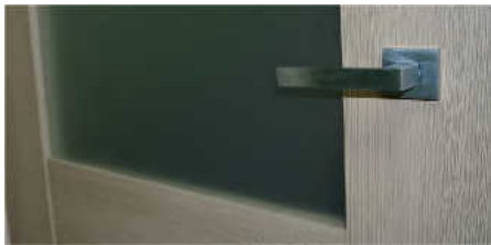
Скло «Сатин», встановлене без обклади в паз складових полотна
