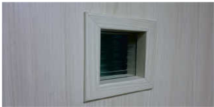
Скло «Жалюзі» встановлене з обкладом (прямокутний)
