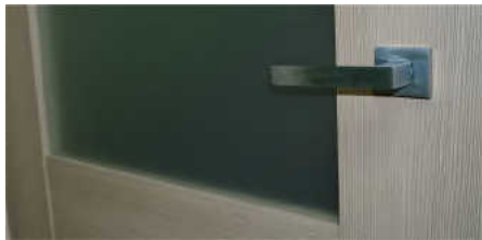
Скло матове, встановлене без обкладу (в паз складових полотна)
