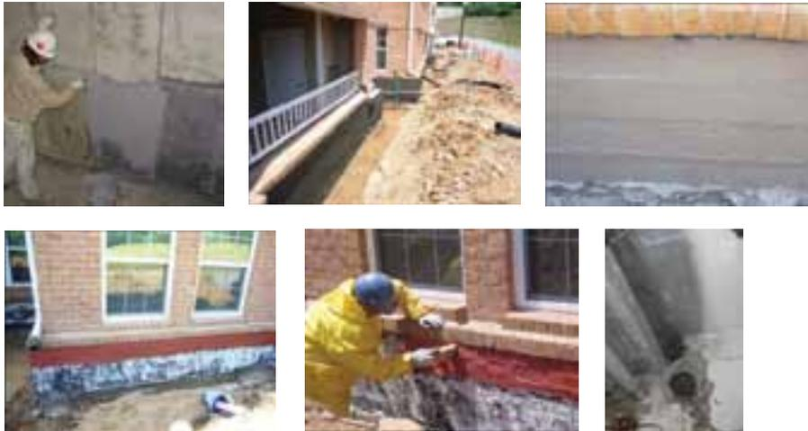
Одной из областей применения системы AQUAFIN-2K/M является гидроизоляция подвалов и фундаментов. При новом строительстве с помощью материала AQUAFIN-2K/M гидроизоляцию заглубленных сооружений можно произвести как снаружи, так и изнутри.
