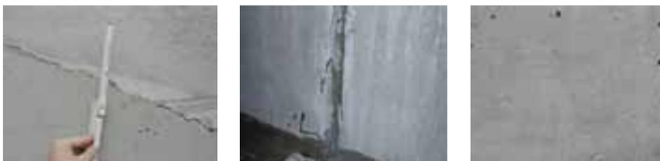
Если подвал уже залит, нужно убрать воду и найти щели и отверстия, через которые поступает вода. С помощью заглушающего цемента FIX-10S, схватывающегося непосредственно после контакта с водой, мгновенно останавливается водоприток и гидроизолируются места локальных протечек. Теперь в подвале не сыро, а просто влажно, и можно начать обследование и обработку стен.
