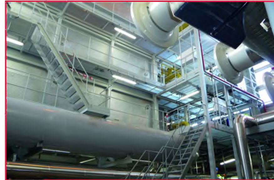
Завод FIAT Італія, м. Турин Котельня 15 т. п./год Котел: VTF-15000/12 – 1 шт.
