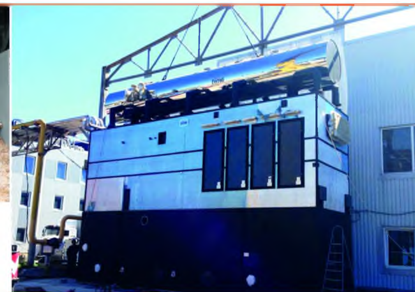
Зернопереробний завод Бікорм смт. Малинівка КУМ 8,5 т.п./год, 1,2 МВт Котли: Ві COMB SGM HP 5000 – 1 шт., FOREST 600 – 2 шт. (тріска)
