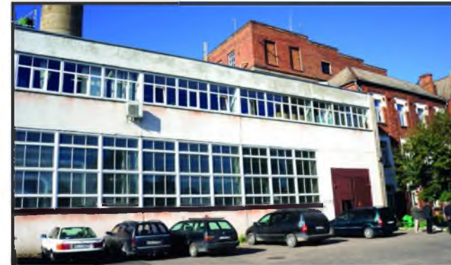
Даугавпильські теплові мережі Латвія, м. Даугавпилс Котельня 17,4 МВт Котел: Eurotherm-17/115 – 1 шт.
