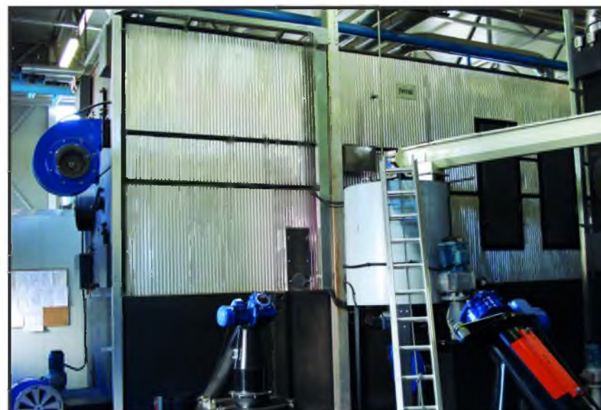
BARLINEK м. Вінниця КУМ 9,3 МВт Котли: Ві COMB SGM ASL 4000 – 2 шт. (тріска)
