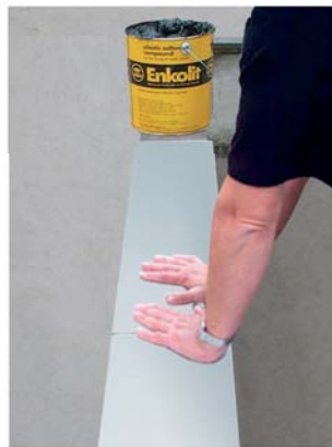
Рівномірне дотискання на металевий аркуш
