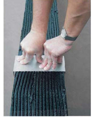
Приклеювання компенсаційної пластини
