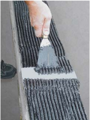
Нанесення Enkolit на компенсаційну пластину
