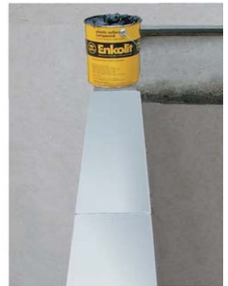
Приклеєний елемент з металу
