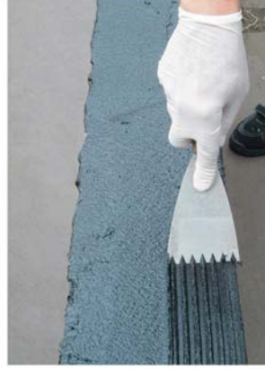
Вирівнювання Enkolit зубчатим шпателем
