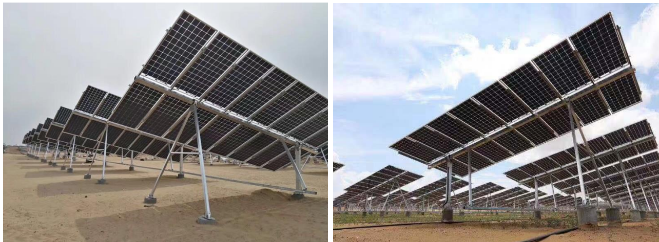
Мал. 2. Одноосьова трекерна система типу ZRT.
