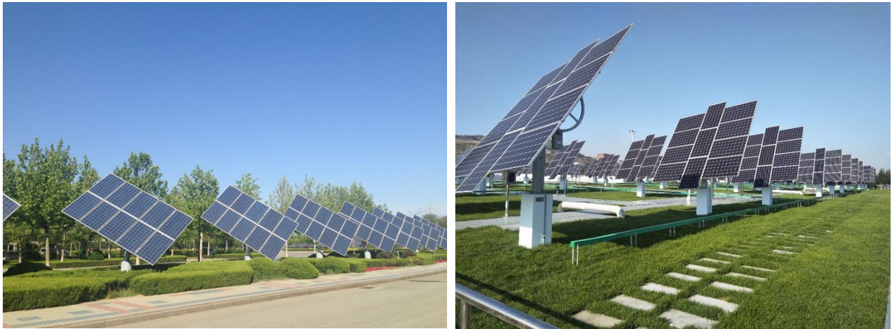
Мал. 3. Двоосьова трекерна система типу ZRS.
