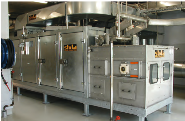
Проект: Oberes Wipptal Австрия Тип: РВТК 1/1000-5 Продукт: осадки сточных вод Производительность испарения воды: 100 кг/ч
