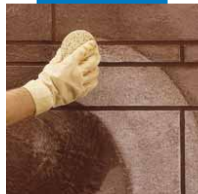
Окончательная очистка плитки губкой
