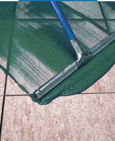
Заполнение швов на полу составом Ultracolor Plus с помощью шабры с резиновым наконечником
