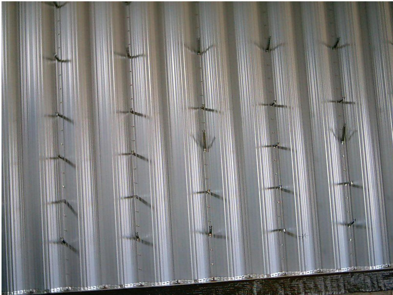
Изоляционные крючки также устанавливаются постепенно по мере монтажа здания. Изоляционные крючки устанавливаются на 1200 мм ц/ц, если не указано другое на чертежах. Удерживающие планки устанавливаются на каждом втором крючке.
