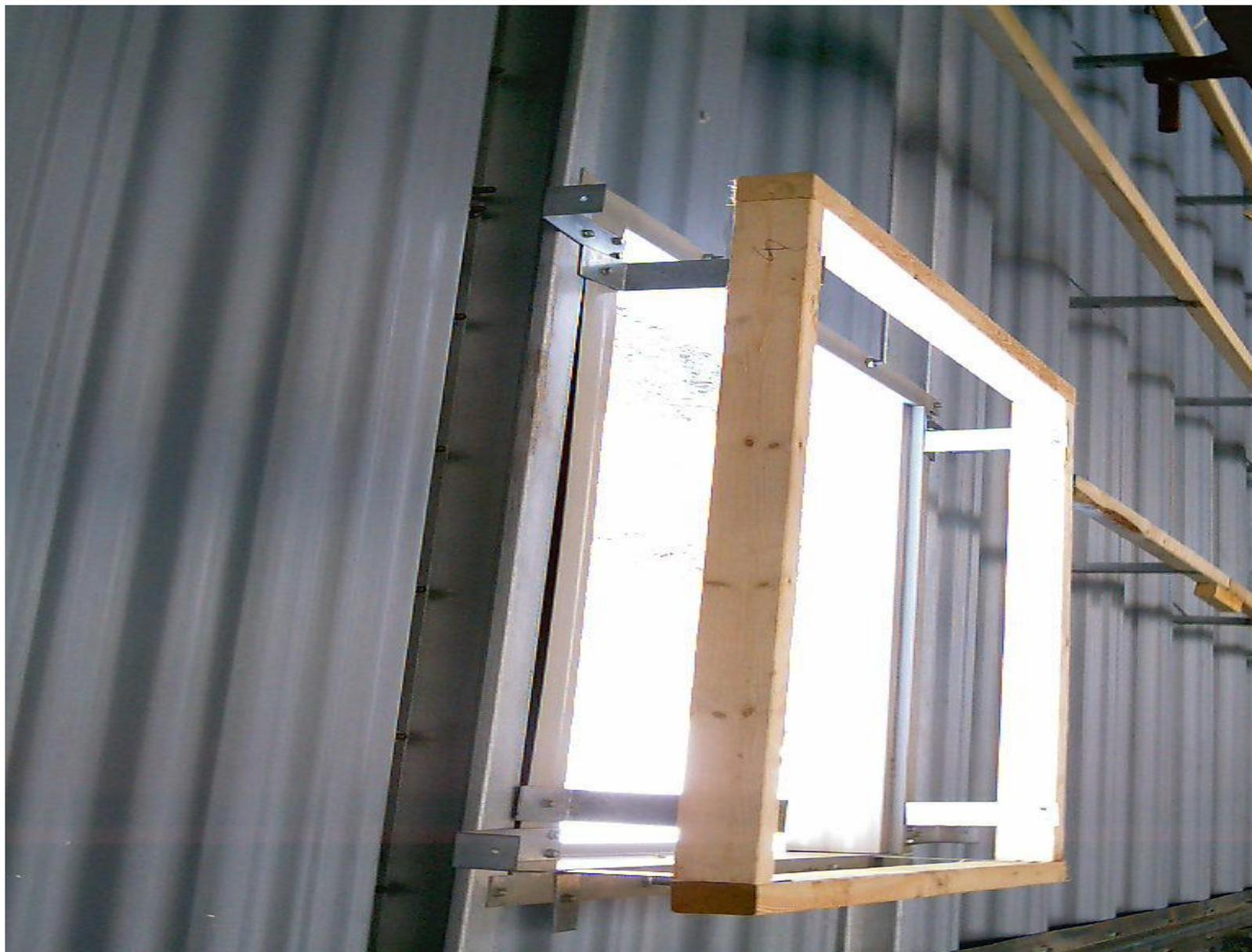
Деревянная обрешетка устанавливается по периметру проемов. Детали определяются на строительных чертежах.
