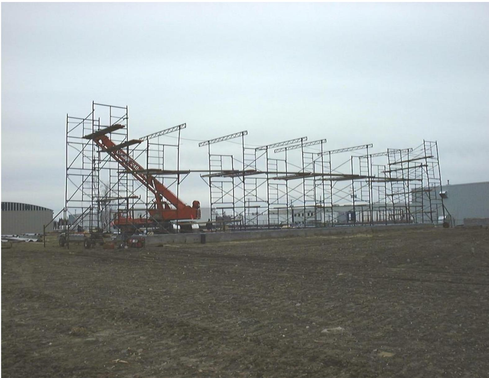
Под руководством руководителя монтажной группы часть команды монтажников проверяет фундаменты, их прямоугольность и расположение анкерных болтов согласно строительным чертежам.
