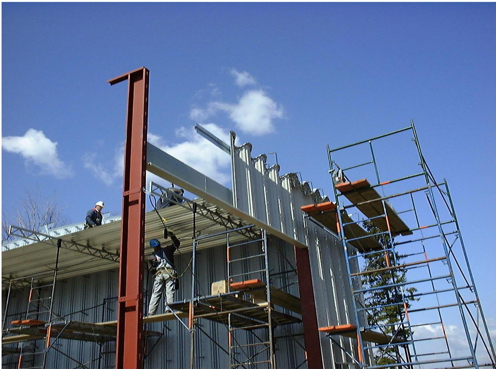
По мере монтажа здания монтируются основные элементы, такие как структурные рамы. Второстепенные компоненты: фартук и декоративные формовки устанавливаются только после того как главная часть здания смонтирована и кран покинул площадку.
