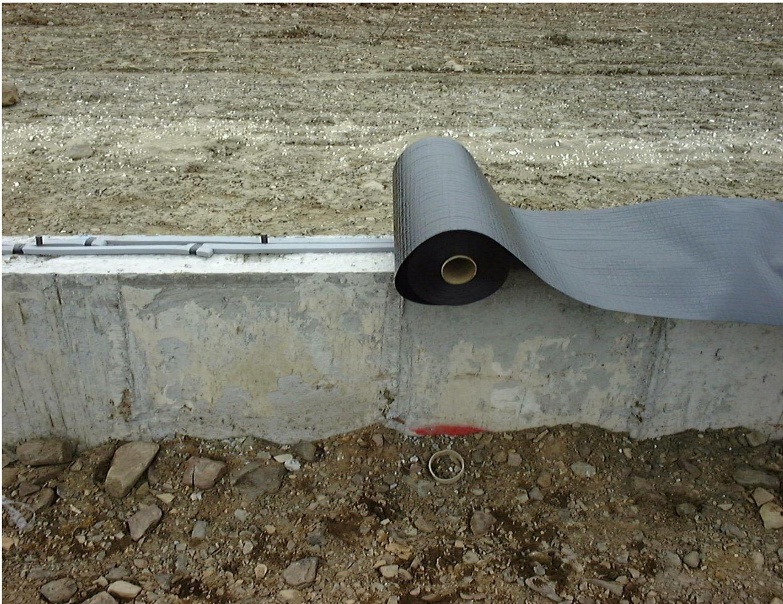
Водонепроницаемая мембрана используется для герметизации стен здания Nonco. Водонепроницаемая мембрана укладывается поверх фундаментных стен. Мембрана выступает внутрь здания, обеспечивая герметизацию внутренней стены.
