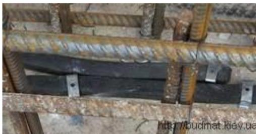
Укладка жгутов Гидростоп в замкнутом пространстве ограничивает их свободное набухание. Проникающая вода в бетон приводит к возникновению не пропускаемого геля, который становится водонепроницаемым барьером и под воздействием давления разбухания наполняет и уплотняет поры и трещины в бетоне. Минимальная бетонная «обертка» жгута составляет 100 мм. В условиях проявления гидростатического давления, ширина щели в элементах уплотнённых жгутами Гидростоп не может превышать 0,5 мм.
