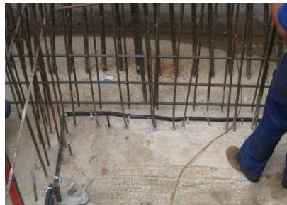
"ГИДРОСТОП" – гидроизоляционный разбухающий бентонитовый шнур – представляет собой продукт, предназначен для обеспечения водонепроницаемости рабочих швов в строительных конструкциях и мест прохождения коммуникаций. При контакте с водой бентонитовая глина значительно увеличивает свой объем. Полученный гель в замкнутом пространстве создает напряжение, понижающее водопроницаемость, даже при наличии трещин и пористых мест в бетоне.
