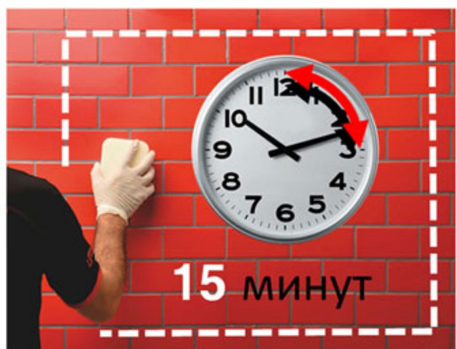
Рекомендуется наносить продукт на участки, не превышающие 3-4 м<sup>2</sup>, которые могут быть очищены в течение 15 минут. При температурах, близких к +30 °C, рекомендуется наносить продукт на участки не превышающие 1 м<sup>2</sup> и немедленно приступить к очистке.
