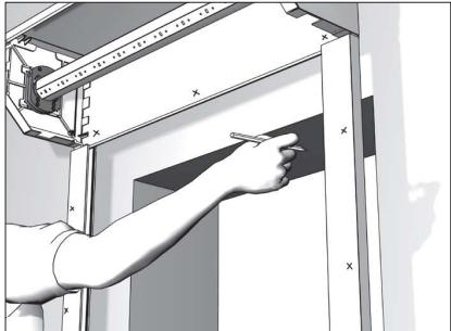
Прислоните конструкцию к стене и отметьте карандашом отверстия на направляющих и коробе для крепления каркаса роллеты к стене.
