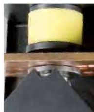
Пробивка отверстий SH 403, SH 404, SH 409
