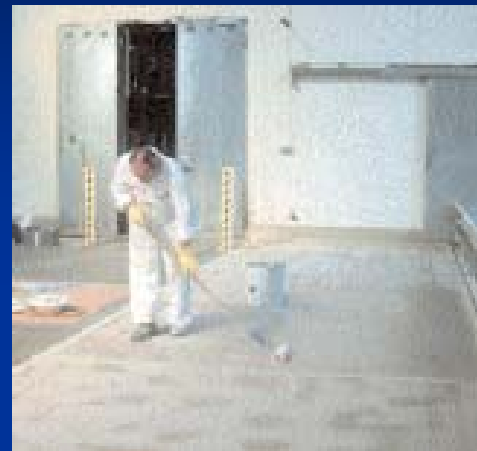
INDUFLOOR-IB 1225 Грунтовка-GWS, Защита водной среды (нанесение валиком)
