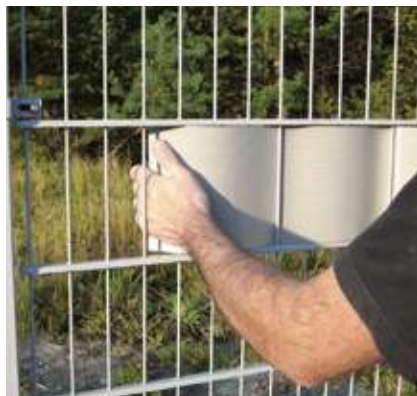
Taśma ogrodzeniowa montowana na panelach ogrodzeniowych.
