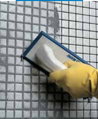
Шпаклевка стенового покрытия из стекломозаики (в туалет) с помощью шпателя
