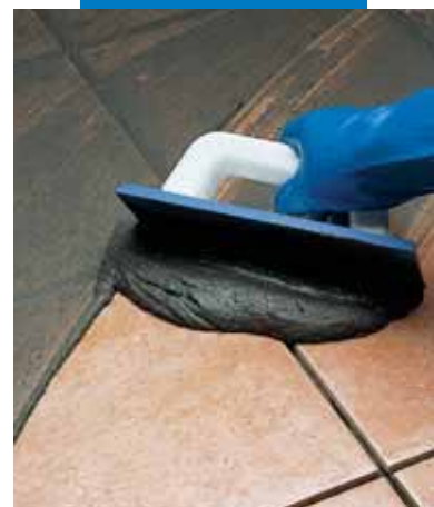
Шпаклевка плитки одинарного обжига шпатлем
