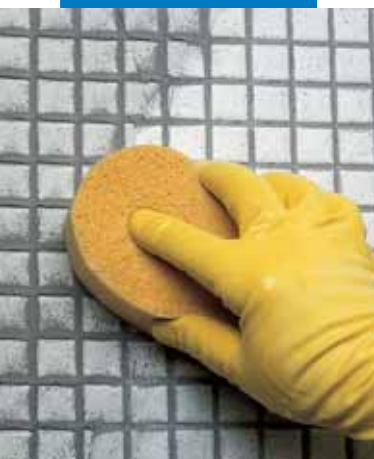
Отделка стенового покрытия из стекломозаики губкой
