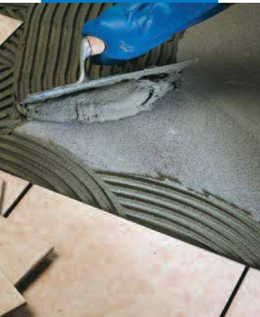
Укладка плитки одинарного обжига на пол
