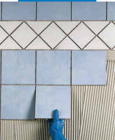
Укладка плитки одинарного обжига на стены из гипсокартона
