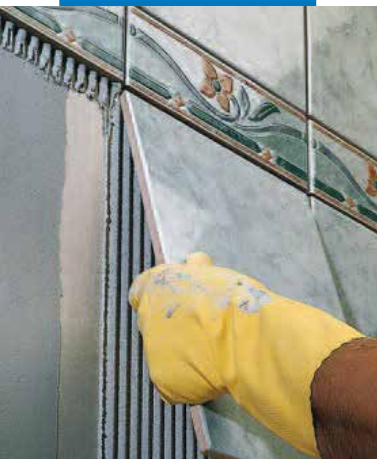
Укладка плитки одинарного обжига на оштукатуренные стены
