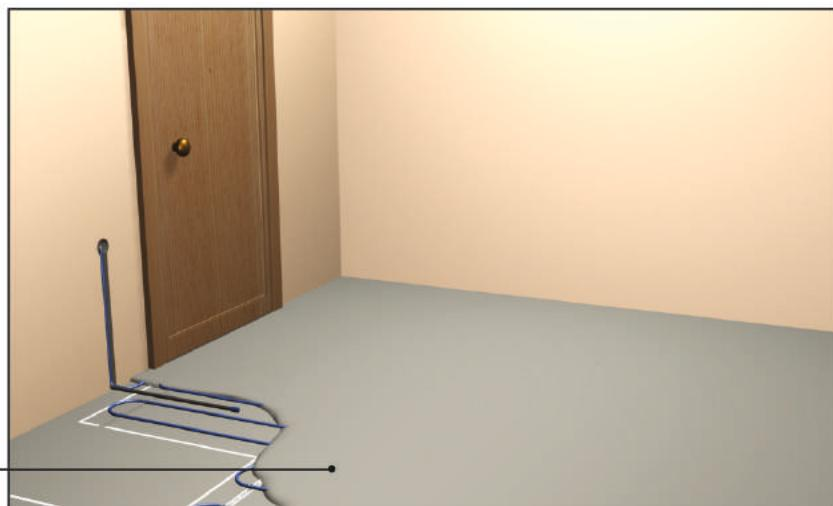
**10.** Перед укладкою фінішного покриття перевірте цілісність кабелю та ізоляції шляхом виміру опору згідно рекомендацій у першому абзаці пункту 5 на ст. 7 Інструкції.
