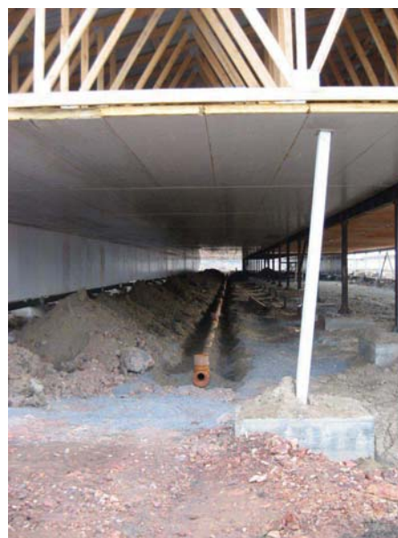
Установка труб навозоудаления
