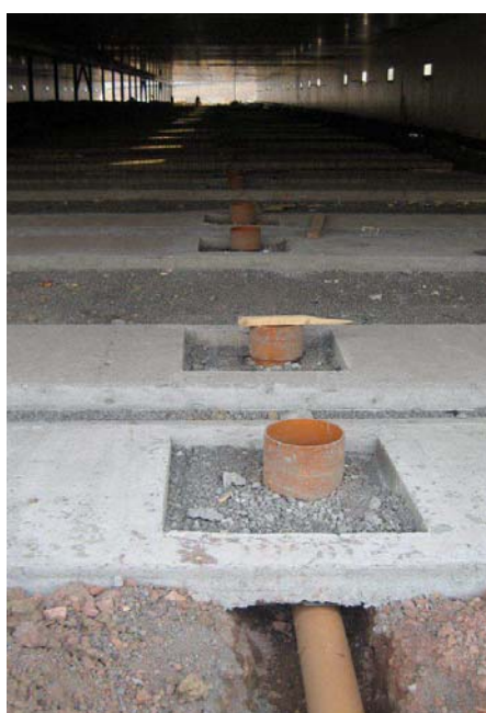
Установка труб навозоудаления
