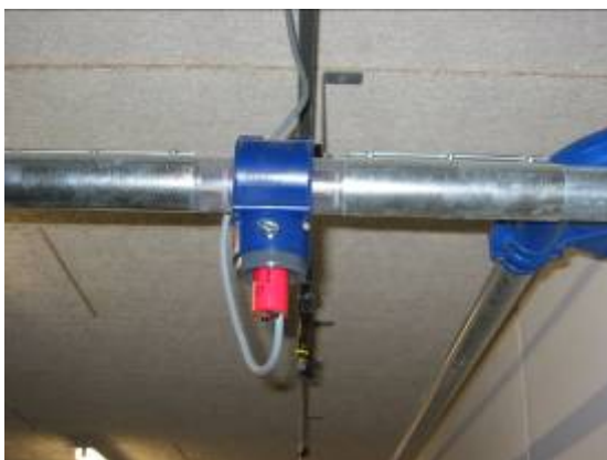
Датчик заполнения всех объемных дозаторов и остановки подачи корма Skiold
